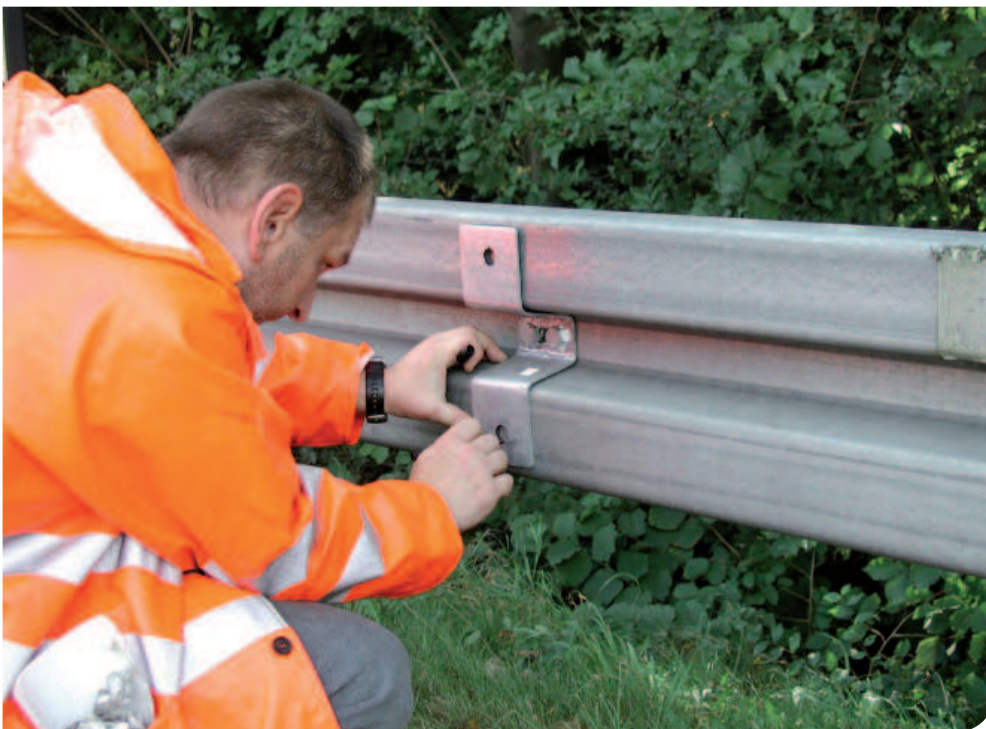
Mitarbeiter der Bundesanstalt für Straßenwesen bei einer nachträglichen Messung mit Schablone
