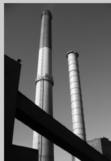
Vorhandener Schornstein (links) und Notschornstein
