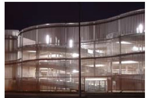
Parking Métro des Argoulets Toulouse (31) France Architecte: Azema Architectes Toulouse (31) France Architecte associé: Tsuba Lyon (69) France Photograph: Pierre Azema
