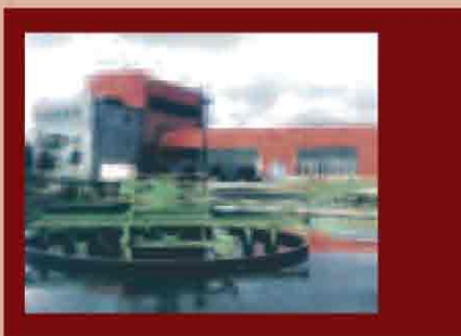
„Dostavba čistíren odpadních vod“ (závod 4 – Energetika)
