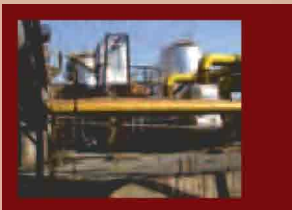
„Obnova Chemie – II. etapa“ (závod 10 – Koksovna)
