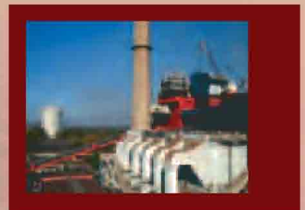
„Rekonstrukce kotle K11“ (závod 4 – Energetika)
