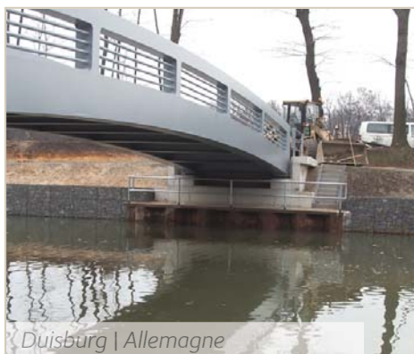
Blindage de fouille | Allemagne
