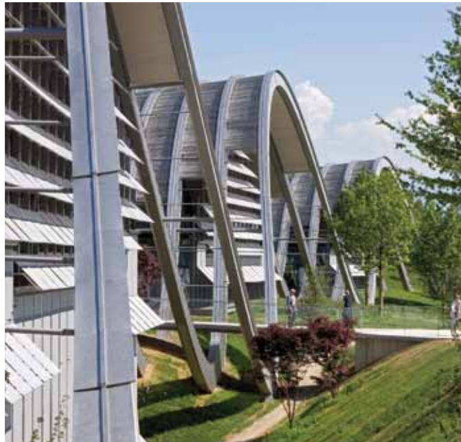
Zentrum Paul Klee, Suisse Renzo Piano Building workshop En collaboration avec ARB (Bern) © RPBW – Michel Denancé Réalisé avec les nuances 304, 316L d'aspect UGITOP
