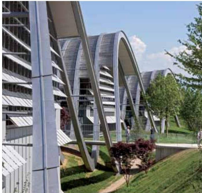
Zentrum Paul Klee, Suisse Renzo Piano Building workshop In Zusammenarbeit mit ARB (Bern) © RPBW – Michel Denancé Ausgeführt mit den Werkstoffen 304, 316L Oberfläche UGITOP
